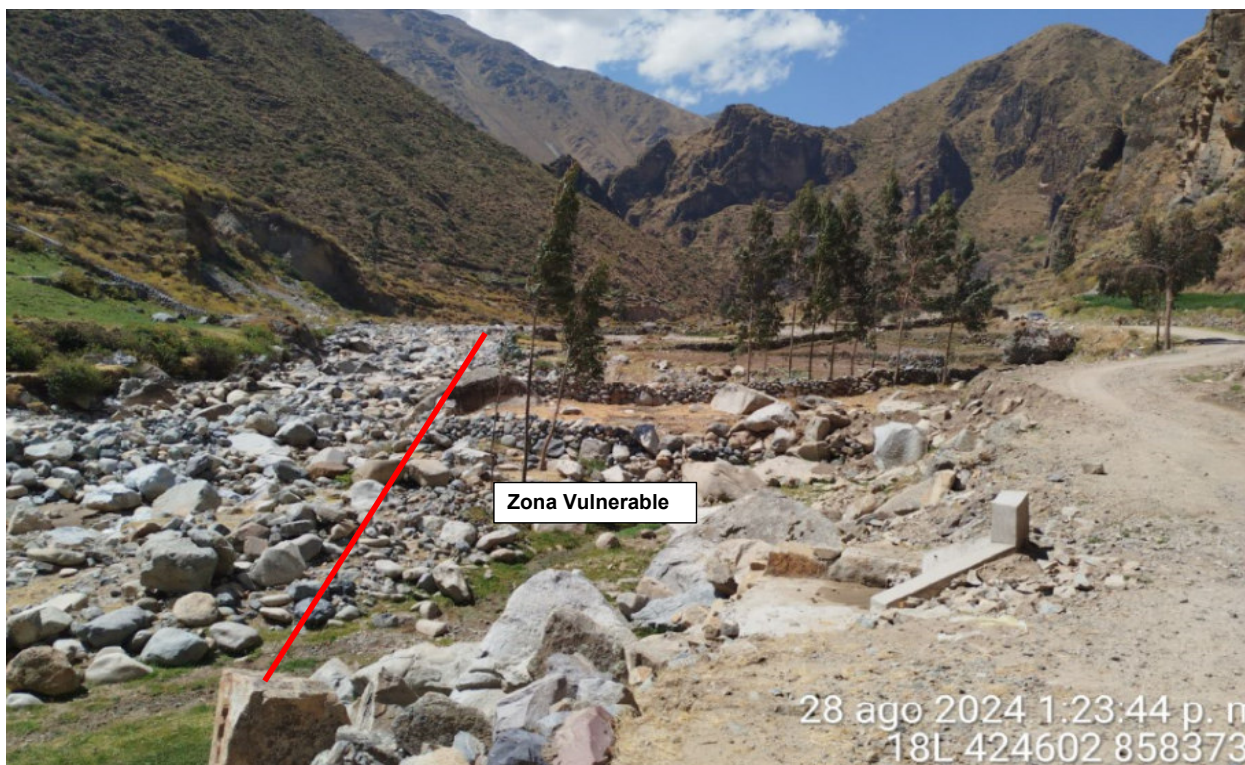
FIGURA N°02: SE OBSERVA LA MARGEN IZQUIERDA DEL RIO EL CUAL ES VULNERABLE ANTE UNA CREDIDA, POR DICHO LADO SE ENCUENTRA COMPLETAMENTE EROSIONADA.
